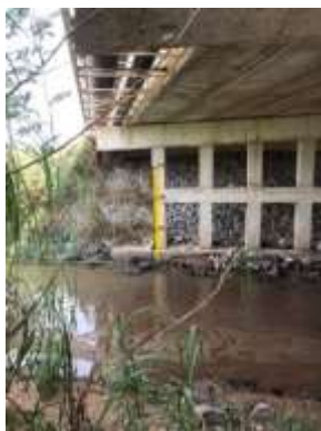
ภาพที่ 2.19 เสาว์วัดระดับความลึกของน้ำ
